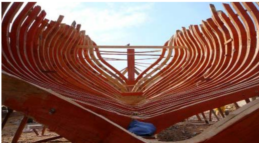
Obr. 36 – Mechanicky spojovaná žebra
