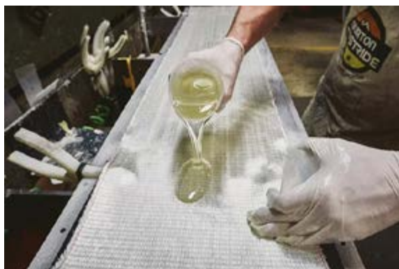
Obr. 20 – Nanášení epoxidové pryskyřice na rohož skelného vlákna (firma Burton)
