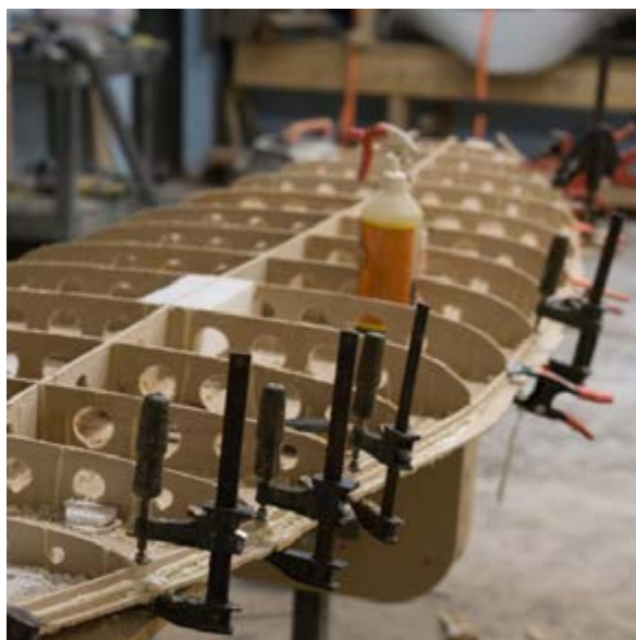
Obr. 28 – Tvorba konstrukce paddleboardu
