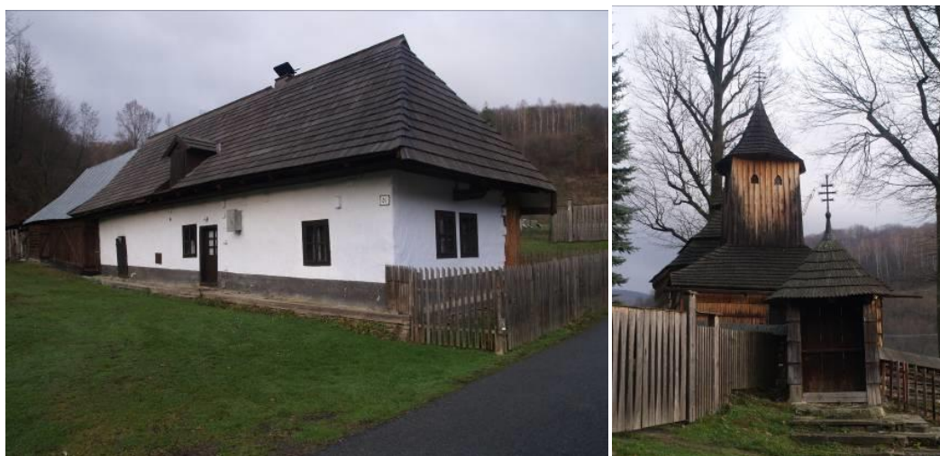
Obr. 6.1 Jedľové drevo sa využíva najmä ako stavebný (konštrukčný) materiál, pre výrobu šindľov a sudov, na vodné stavby (člny, pilóty, hate) a pod. (foto: zrubový dom v Nižnom Komárniku)
