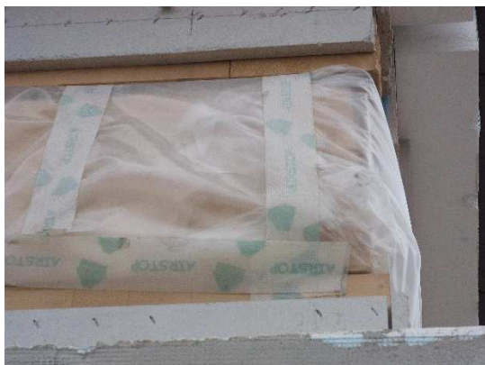
Obrázek 88 Parozábrana venkem.
