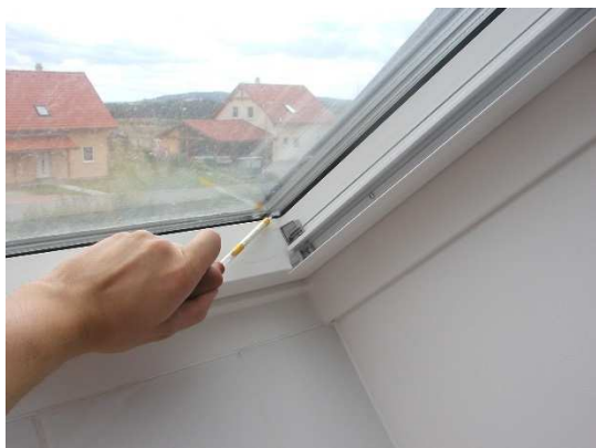
Obrázek 78 Zasklívací spára střešního okna.
