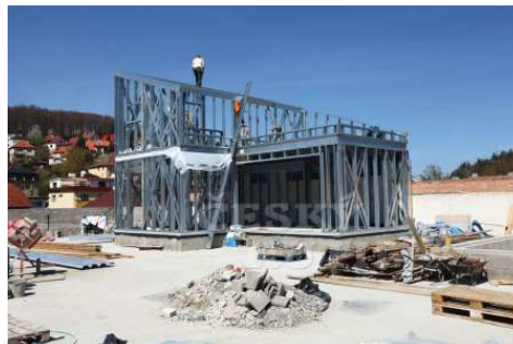
Obrázek 11 Ocelová konstrukce Lindab.[59]
