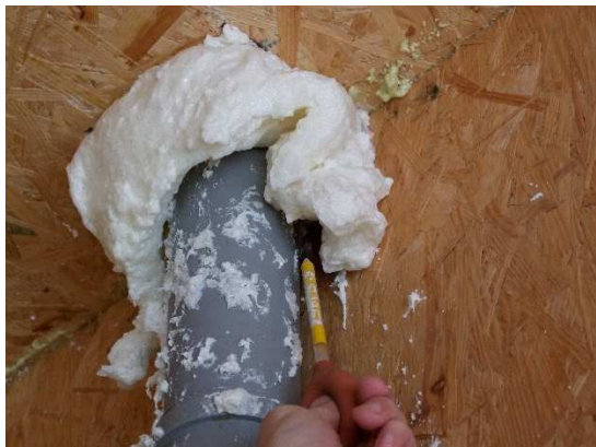
Obrázek 100 Těsnění PUR pěnou.
