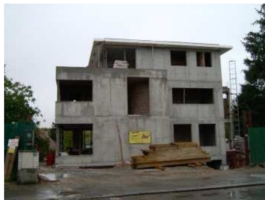
Obrázek 5 Těžká obvodová konstrukce. [57]
