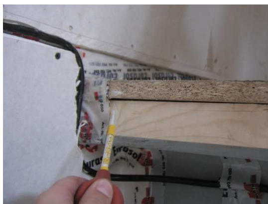
Obrázek 91 Neprolepený otvor pro schody.
