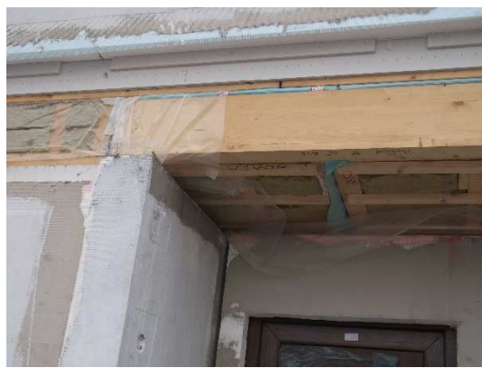
Obrázek 87 Nenapojená parozábrana.
