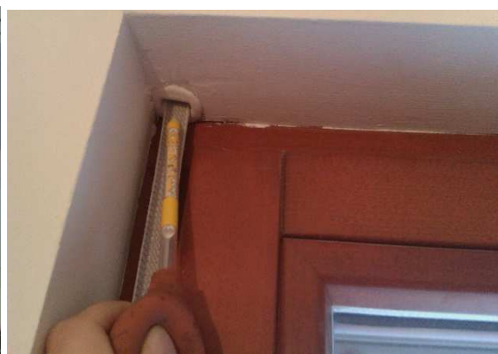
Obrázek 103 Únik přes ovládání předokenních žaluzií.
