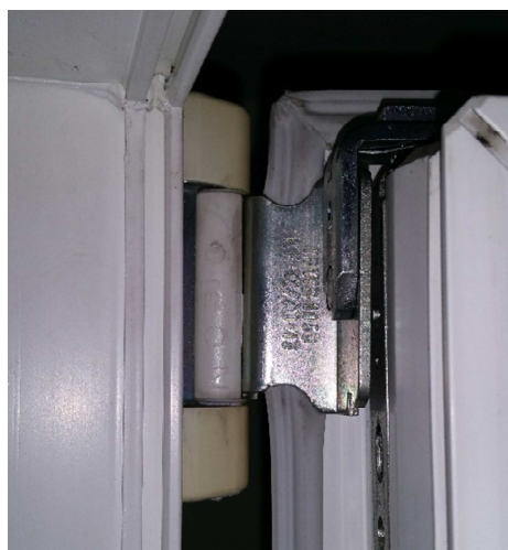
Obrázek 70 Horní pant u sklopně otvíravých otvorových výplňích.
