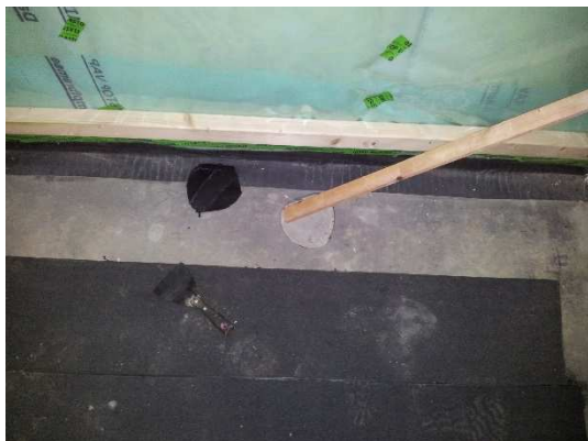
Obrázek 82 Spoj na butylový pásek.
