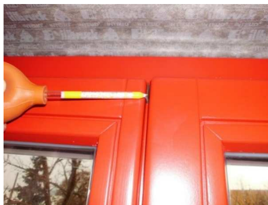
Obrázek 71 Dřevěné okno na sraz.
