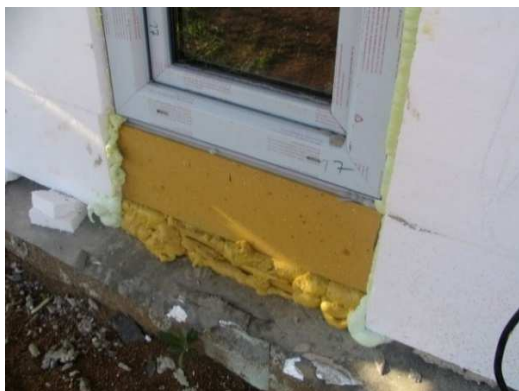
Obrázek 64 Instalace pouze na PUR pěnu.
