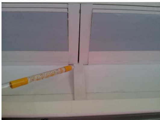
Obrázek 104 Únik z interiéru do roletových boxů.
