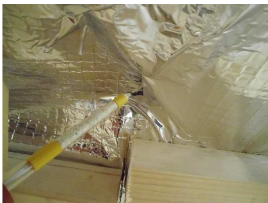
Obrázek 94 Spoj parozábran, takzvaný varhánek.
