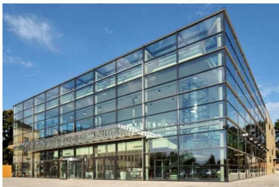
Obrázek 6 Lehká obvodová konstrukce. [56]
