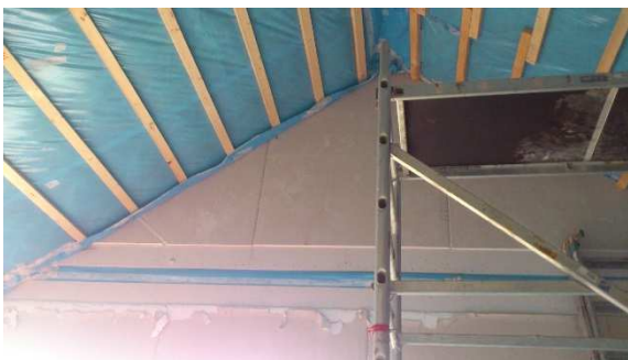
Obrázek 43 Zabezpečení vzduchotěsnicí vrstvy.
