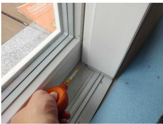
Obrázek 73 Spodní kování posuvných dveří.
