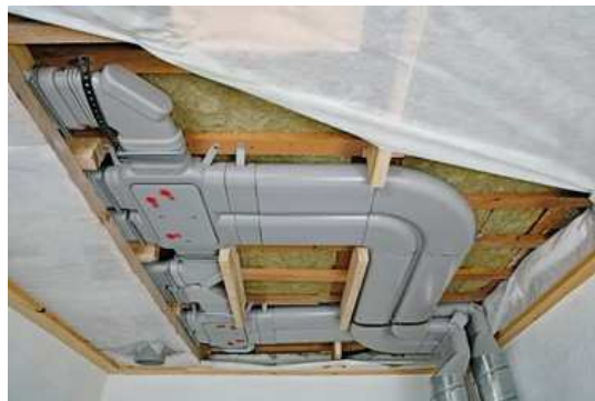
Obrázek 29 Rozvody centrální rekuperace. [67]
