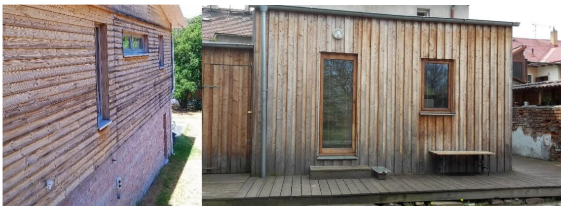
Obrázek 3.2: Nerovnoměrné zešednutí neošetřené fasády (foto Oberhofnerová a Trgala)
