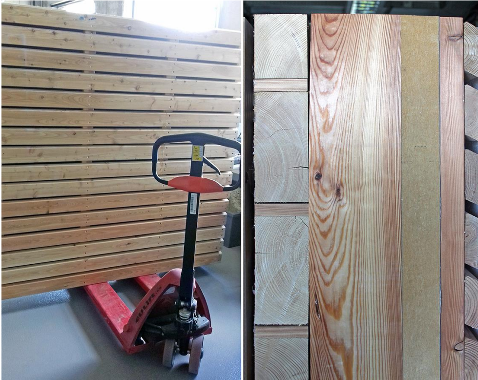
Příloha 21: Panel zateplené roubené stěny ze smrkových profilů (ozn. 7)
