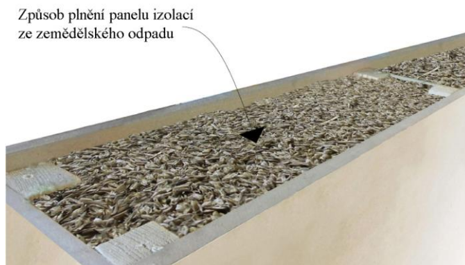
Obrázek 19: Způsob plnění obálky panelu (z MDF desek) izolací ze zemědělského odpadu (na obrázku ukázka pšeničných plev)
