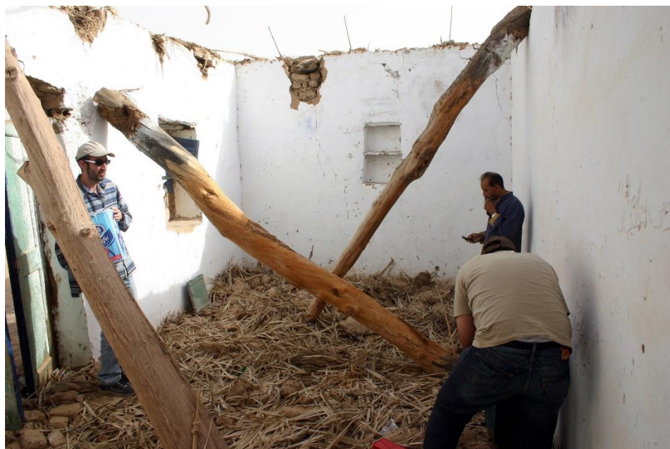
Obr. 12: Zhroucený krov po napadení termitem rodu Psammotermes hybostoma (Rhinotermitidae). Foto: Osobní archiv Jana Šobotníka
